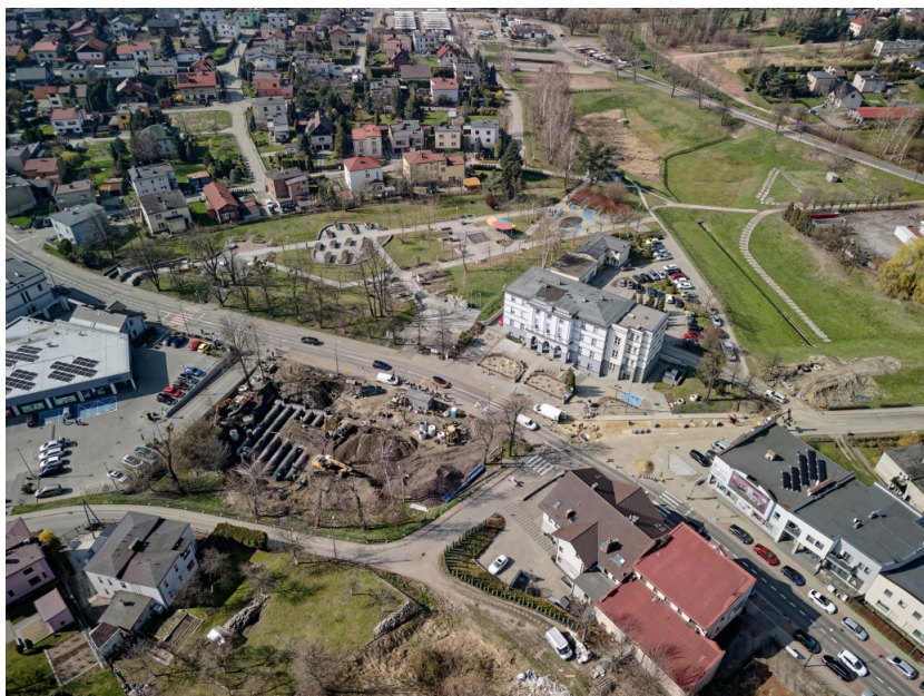
Realizacja zadania: Budowa zabezpieczeń przeciwpowodziowych na terenie Miasta Rydułtowy
