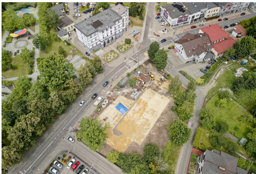
Realizacja zadania: Budowa zabezpieczeń przeciwpowodziowych na terenie Miasta Rydułtowy
